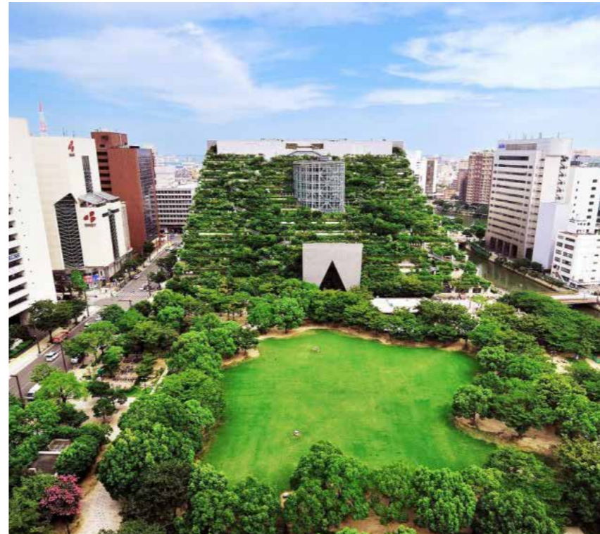
Het dak als landschappelijke voortzetting (Acros building,, Japan)
